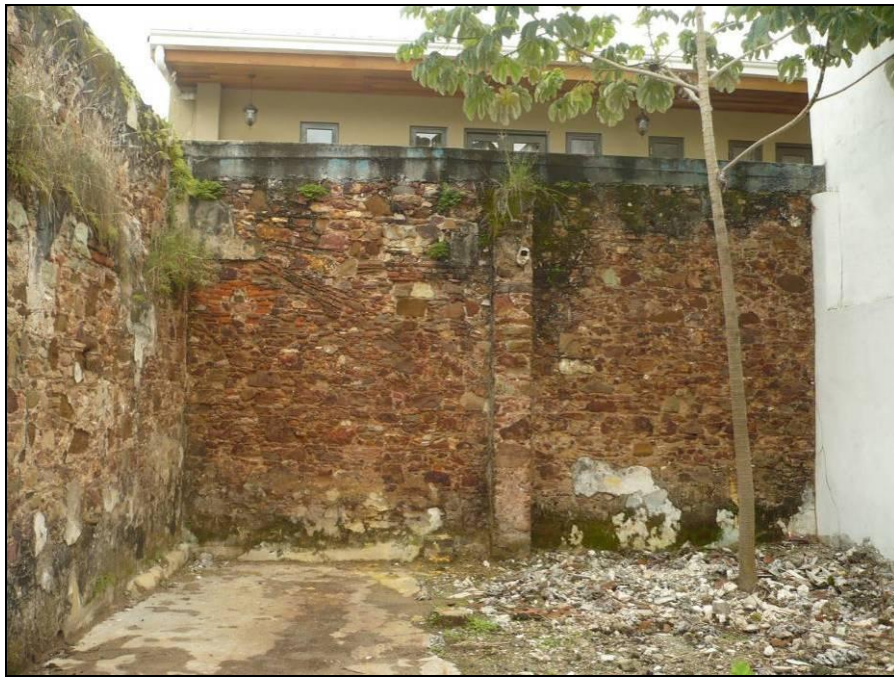
Patio de la finca 2147. Nótese sobre la pared del fondo (oriental) la huella diagonal de un techo que otrora tuvo el cañón de la casa, que discurría en dirección este-oeste.
