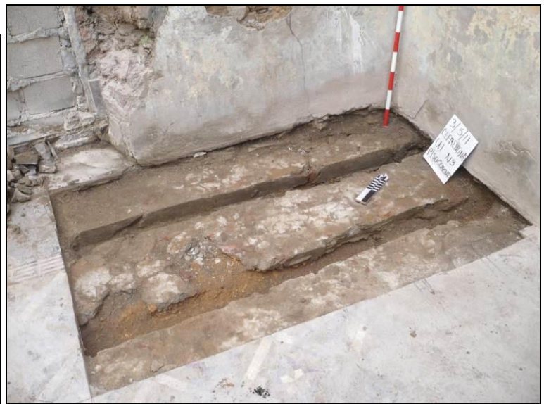
Unidad 1 desde el sur. A la izquierda, el piso actual de mosaicos de pasta. A la derecha, nótese las láminas de cemento en las que se insertaron durmientes o travesaños de madera.
