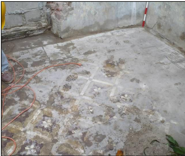
Unidad 1 desde el sur. A la izquierda, el piso actual de mosaicos de pasta. A la derecha, nótese las láminas de cemento en las que se insertaron durmientes o travesaños de madera.
