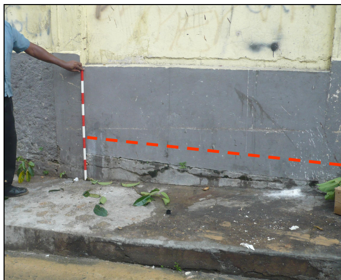
Fachada de la finca 9635. La línea roja punteada indica la altura a la que termina, por dentro de la casa, el cimiento de piedras sillares.
