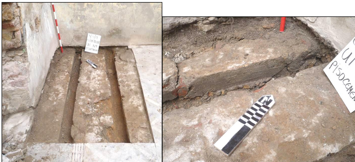
Unidad 1. A la derecha, nótese la impronta que dejó la madera en el cemento fresco del piso.
