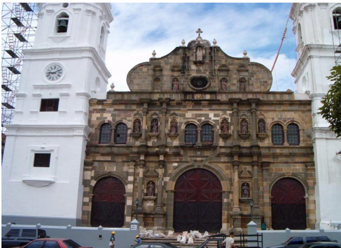
Foto #7. -Vista general de la Portada de la Catedral en la actualidad, después de labores de limpieza. Puede observarse la distinta coloración que presentan sus sillerías (Foto Domingo Varela, 2003)
