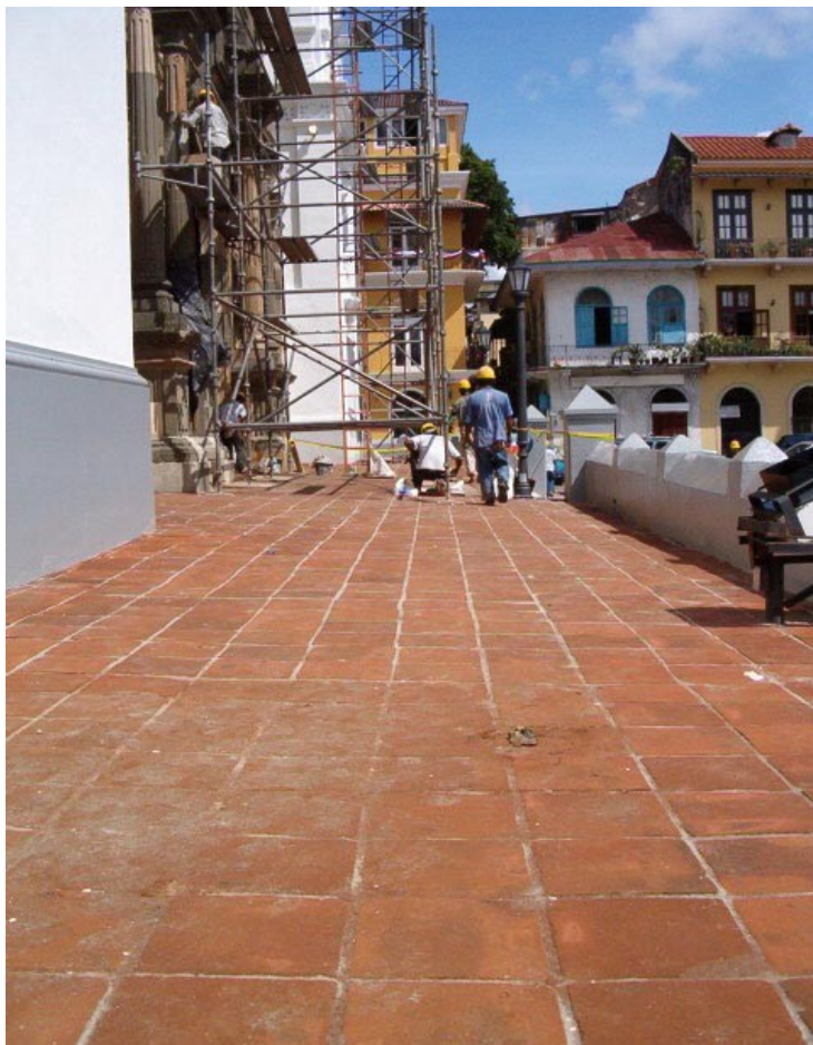
Foto #10. -Colocación del nuevo piso de baldosas de arcilla en el atrio. (Foto Domingo Varela, 2003)
