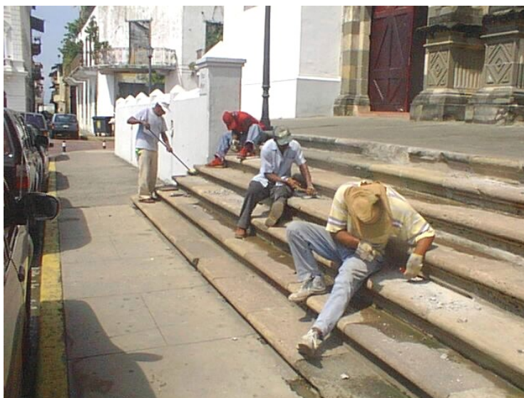
Foto #9.- Trabajos de cantería para restaurar los escalones deteriorados en las escaleras de la entrada principal de la Catedral. (Foto Domingo Varela, 2003)
