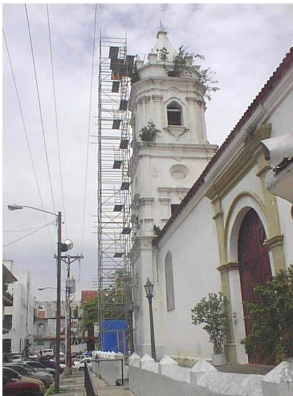
Foto #8.- Labores de limpieza de la vegetación en la torre derecha de la Catedral, en mayo de 2003. Obsérvese la gran cantidad de arbustos sobre los paramentos y cornisas, los cuales estaban agrietando las mamposterías. También puede observarse la rampa para discapacitados. (Foto Domingo Varela)
