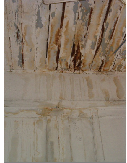
Fotos #45, 46 y 47.- A la izquierda podemos apreciar el desprendimiento del marco decorativo y las grietas en la losa, la cual ha rotado. En el centro se observan los daños encontrados en los pisos por ataque de insectos xilófagos y en la foto derecha se ven los daños en las láminas del cielo raso y las paredes producto de las humedades por filtraciones superiores.
