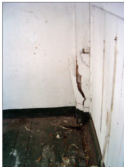
Fotos #63, 64 y 65. -A la izquierda, vista de los daños provocados en el muro y en el cielo raso por las filtraciones provenientes de cubierta. Al centro podemos apreciar la rotura y desprendimiento de una sección de concreto en una columna y las humedades presentes en el piso de una de las habitaciones del Patio #2. A la derecha, daños provocados por la fuga en una tubería de desagüe oculta en una de las paredes de madera.
