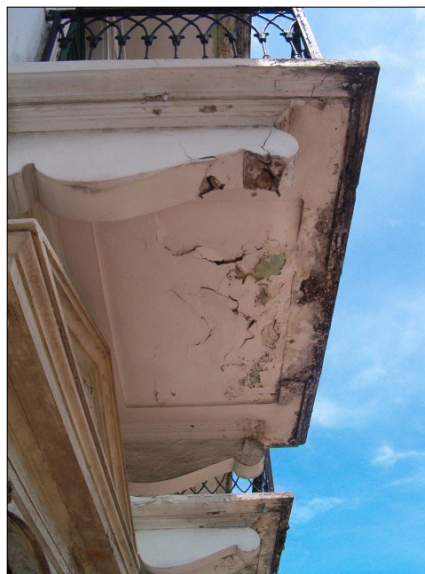
Fotos #42, 43 y 44. -Vistas parciales de los balcones del primer alto, daños encontrados en parte baja de las losas y ménsulas y vista parcial de los balcones del segundo nivel.
