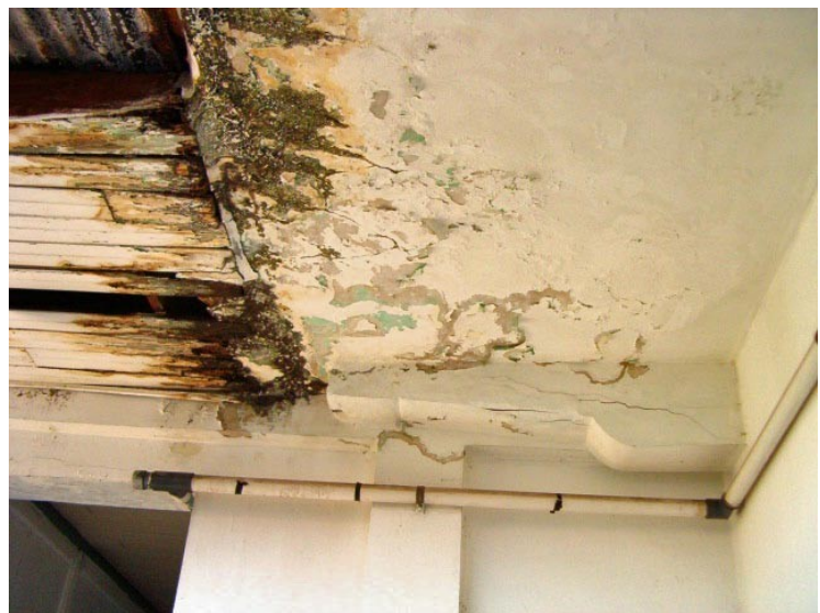
Foto #62.- Vista general de los daños ocasionados por filtraciones provenientes de cubierta en losa y alero de madera machihembrada
