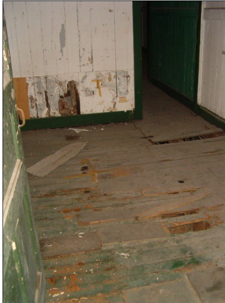
Fotos #48 y 49.- Vistas de la presencia de raíces de un árbol, pudrición de cielos rasos y daños en el muro. En la segunda foto se aprecian los daños ocasionados por las filtraciones en los pisos y paredes
