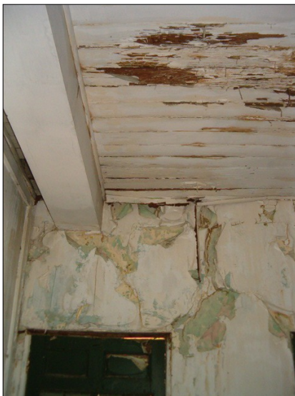
Fotos #63, 64 y 65. -A la izquierda, vista de los daños provocados en el muro y en el cielo raso por las filtraciones provenientes de cubierta. Al centro podemos apreciar la rotura y desprendimiento de una sección de concreto en una columna y las humedades presentes en el piso de una de las habitaciones del Patio #2. A la derecha, daños provocados por la fuga en una tubería de desagüe oculta en una de las paredes de madera.
