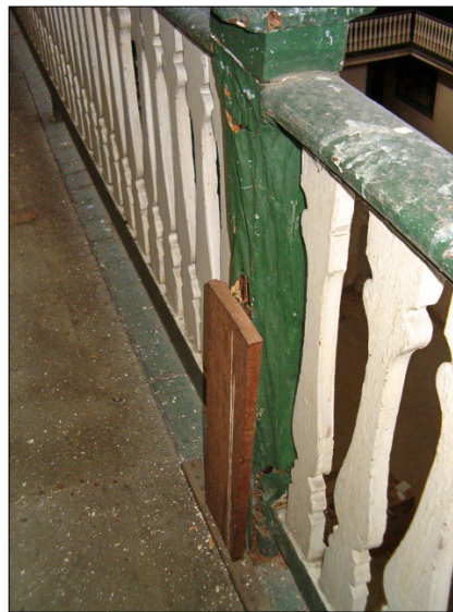
Fotos #10, 11 y 12.- Vistas generales de los daños encontrados en los pasillos. Se pueden apreciar los deterioros en muros, manchas, descascarillamientos de pinturas y desprendimientos de revocos por corrosión de tuberías empotradas, ataque severo de xilófagos en columna y pudriciones y pérdidas de material del entablonado de pisos.
