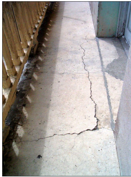
Fotos #57 y 58. -Vistas generales de los daños ocasionados por las filtraciones superiores en cielos rasos y muros de las habitaciones y grietas en la losa de balcón corrido del segundo alto.
