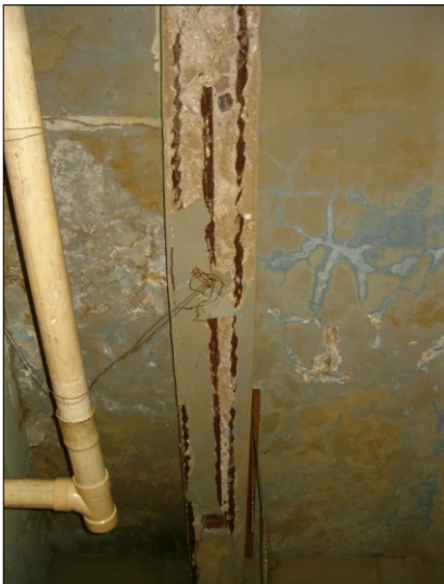
Foto #20.- Vista de la viga en pasillo de servicios sanitarios y del mal estado de conservación de la losa superior, en la cual se aprecian fisuras, eflorescencias y humedades
