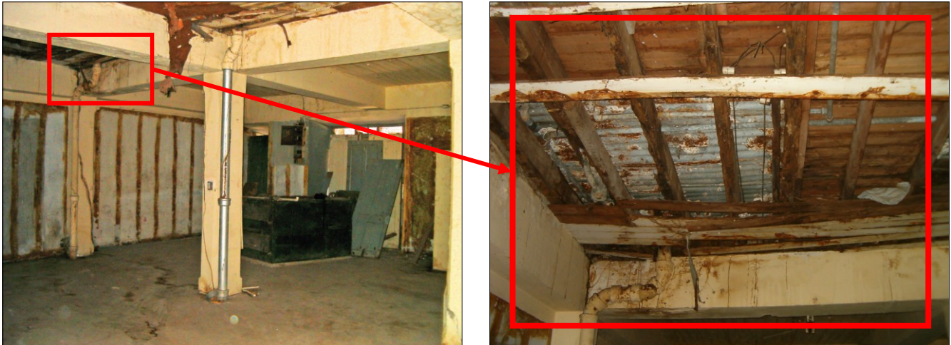
Fotos #31 y 32.- A la izquierda, Vista general de la Panadería. A la derecha podemos notar los graves daños existentes en la estructura de soporte del piso superior, de la madera machihembrada y en las vigas de concreto.
