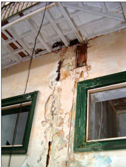
Fotos #10, 11 y 12.- Vistas generales de los daños encontrados en los pasillos. Se pueden apreciar los deterioros en muros, manchas, descascarillamientos de pinturas y desprendimientos de revocos por corrosión de tuberías empotradas, ataque severo de xilófagos en columna y pudriciones y pérdidas de material del entablonado de pisos.
