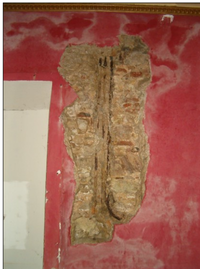
Fotos #24 y 25. -A la izquierda, vista general del estado de las losetas de mármol y las eflorescencias entre las juntas. A la derecha, parte del muro no revocado donde se puede apreciar las mamposterías y tuberías corroídas, manchas de humedades y eflorescencias en el muro
