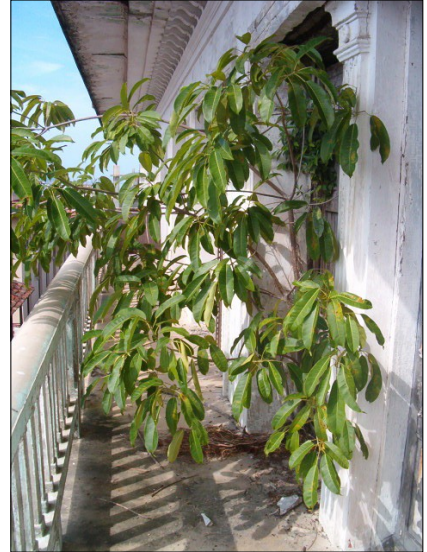
Fotos #59, 60 y 61.- A la izquierda, vista del grave estado de deterioro de las ménsulas que soportan el balcón corrido frente a la Plaza de la Independencia. Al centro se puede apreciar los daños provocados en la losa por efecto del crecimiento de árboles y, a la derecha, vista de un árbol que ha crecido entre el muro y el balcón y cuyas raíces han afectado severamente los interiores de las habitaciones
