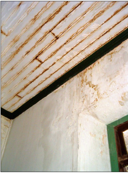
Fotos #57 y 58. -Vistas generales de los daños ocasionados por las filtraciones superiores en cielos rasos y muros de las habitaciones y grietas en la losa de balcón corrido del segundo alto.
