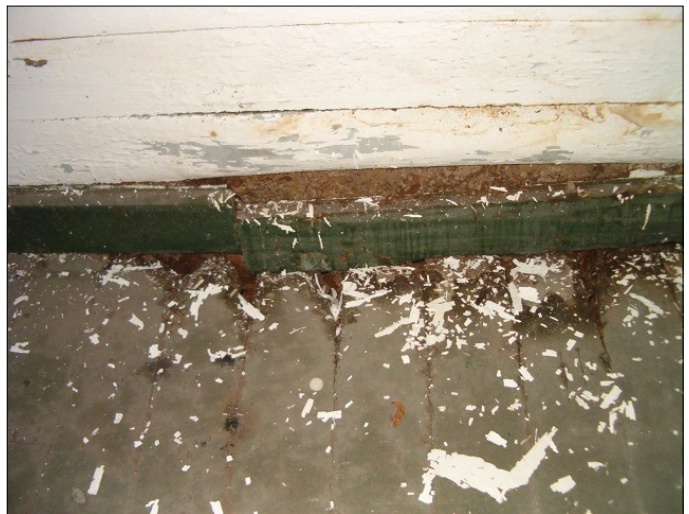
Foto #50.- Vista de las humedades, ataques por insectos xilófagos y hundimiento del piso por pudrición de los cabezales de las vigas
