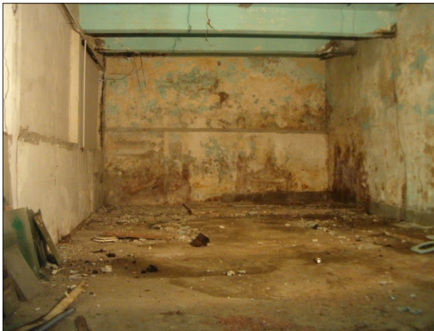
Fotos #14 y 15.- Vistas parciales del Depósito Principal y de su estado de conservación general. Podemos apreciar las humedades y descascarillamientos de pinturas en pisos y muros, además de las suciedades generales. En la foto derecha se muestra el grave deterioro estructural de una parte de la losa de concreto, muro y cabezal de viga
