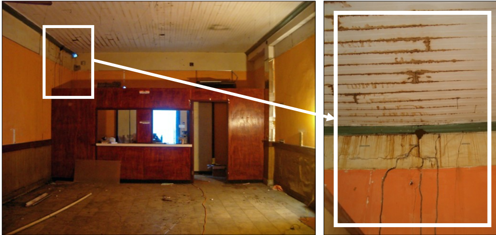
Fotos #21 y 22.- Vista general del área de Billar y de los daños por filtraciones encontrados en el cielo raso y las paredes del ambiente
