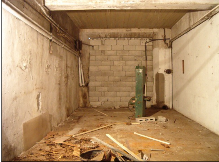
Fotos #37 y 38.- Vista parcial de uno de los Depósitos Secundarios (hacia Calle 4ta.) y del estado de las guías de madera y del desarrollo del foso del montacargas
