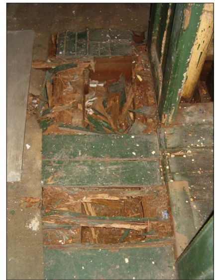
Fotos #10, 11 y 12.- Vistas generales de los daños encontrados en los pasillos. Se pueden apreciar los deterioros en muros, manchas, descascarillamientos de pinturas y desprendimientos de revocos por corrosión de tuberías empotradas, ataque severo de xilófagos en columna y pudriciones y pérdidas de material del entablonado de pisos.
