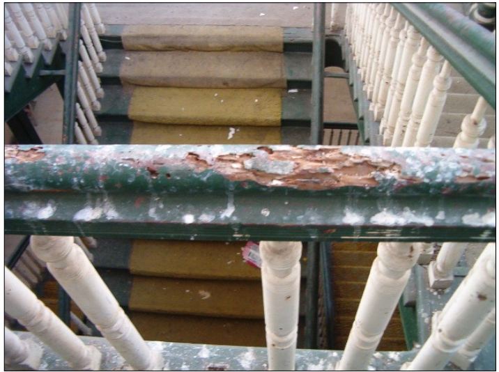
Foto #13.- Vista parcial de un tramo de la escalera y de los daños ocasionados por los insectos xilófagos en el pasamanos y los balaustres. Se puede apreciar también la falta de balaustres en los barandales y suciedades generales.
