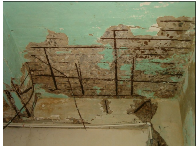
Fotos #14 y 15.- Vistas parciales del Depósito Principal y de su estado de conservación general. Podemos apreciar las humedades y descascarillamientos de pinturas en pisos y muros, además de las suciedades generales. En la foto derecha se muestra el grave deterioro estructural de una parte de la losa de concreto, muro y cabezal de viga
