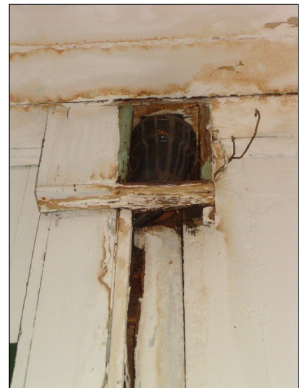
Fotos #63, 64 y 65. -A la izquierda, vista de los daños provocados en el muro y en el cielo raso por las filtraciones provenientes de cubierta. Al centro podemos apreciar la rotura y desprendimiento de una sección de concreto en una columna y las humedades presentes en el piso de una de las habitaciones del Patio #2. A la derecha, daños provocados por la fuga en una tubería de desagüe oculta en una de las paredes de madera.
