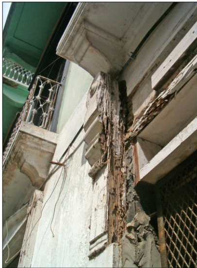
Fotos #72 y 73.- Daños severos por insectos xilófagos en los marcos ornamentales de las puertas en planta baja y vista general de los deterioros en balcones y muros
