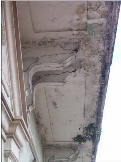
Fotos #59, 60 y 61.- A la izquierda, vista del grave estado de deterioro de las ménsulas que soportan el balcón corrido frente a la Plaza de la Independencia. Al centro se puede apreciar los daños provocados en la losa por efecto del crecimiento de árboles y, a la derecha, vista de un árbol que ha crecido entre el muro y el balcón y cuyas raíces han afectado severamente los interiores de las habitaciones
