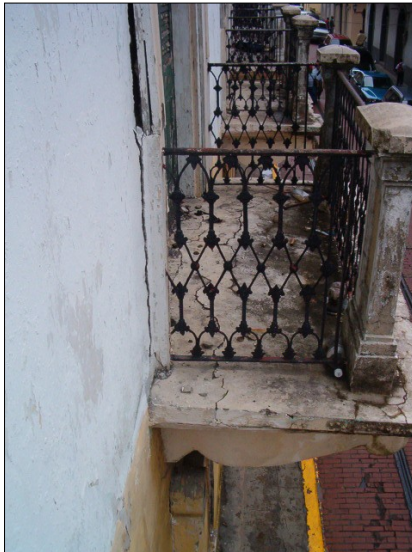
Fotos #45, 46 y 47.- A la izquierda podemos apreciar el desprendimiento del marco decorativo y las grietas en la losa, la cual ha rotado. En el centro se observan los daños encontrados en los pisos por ataque de insectos xilófagos y en la foto derecha se ven los daños en las láminas del cielo raso y las paredes producto de las humedades por filtraciones superiores.
