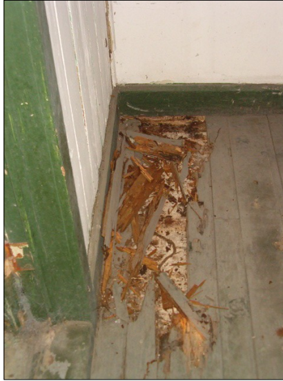
Fotos #45, 46 y 47.- A la izquierda podemos apreciar el desprendimiento del marco decorativo y las grietas en la losa, la cual ha rotado. En el centro se observan los daños encontrados en los pisos por ataque de insectos xilófagos y en la foto derecha se ven los daños en las láminas del cielo raso y las paredes producto de las humedades por filtraciones superiores.
