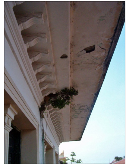
Foto #66.- Vista de los daños en la losa sobre el balcón del tercer nivel
