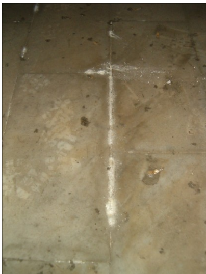
Fotos #24 y 25. -A la izquierda, vista general del estado de las losetas de mármol y las eflorescencias entre las juntas. A la derecha, parte del muro no revocado donde se puede apreciar las mamposterías y tuberías corroídas, manchas de humedades y eflorescencias en el muro
