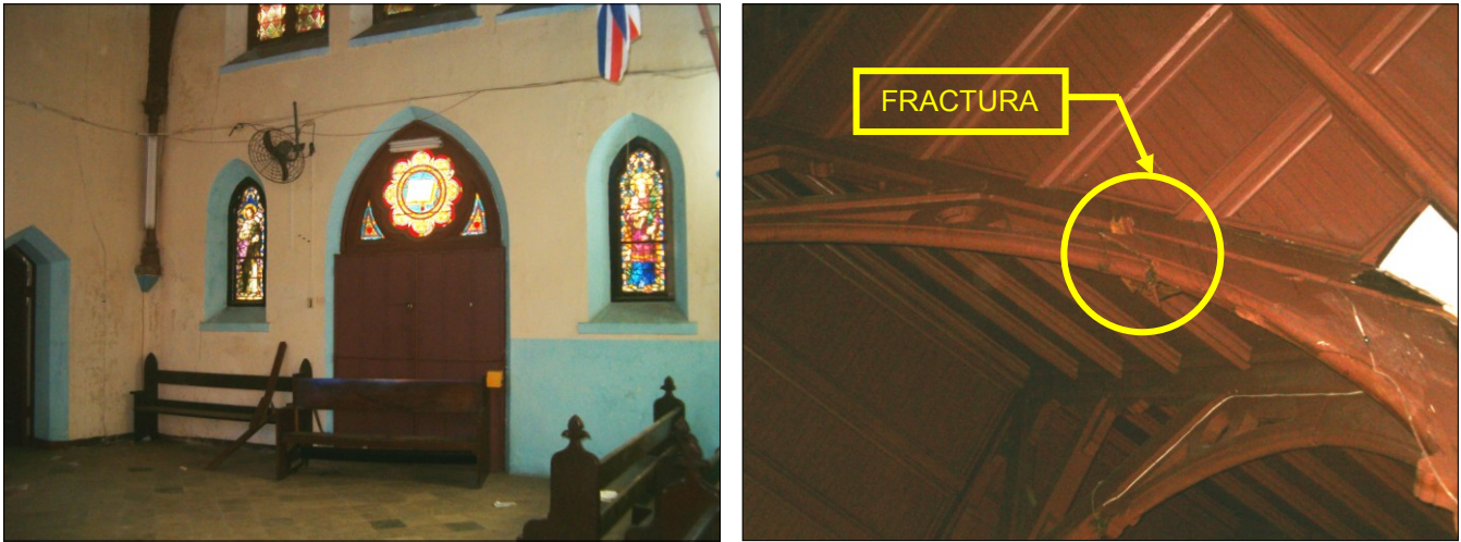
Fotos #11 y 12: Vista parcial del muro testero Oeste (lateral derecho) y de la fractura de una de las cerchas debajo del encuentro de las cubiertas en el Crucero
