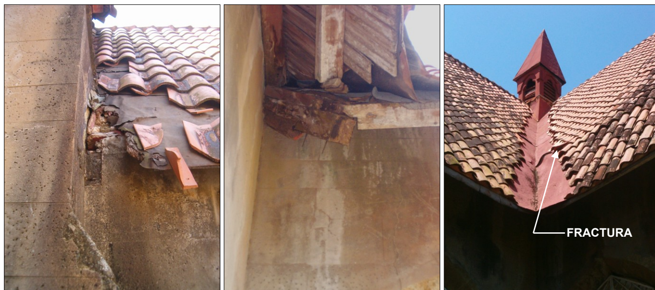
Fotos #35, 36 y 37: Vistas generales de los daños en los faldones de cubierta. Izquierda: Pudriciones y pérdida de tablones, felpas y tejas. Centro: Pudrición de un can y de los elementos inmediatos (tablones y correas). Derecha: Vista del Chapitel superior y de la fractura de los pares en un faldón.
