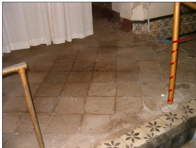
Foto #16: Vista de los daños en el piso del “Altar de las Damas” ocasionados por las humedades ascendentes
