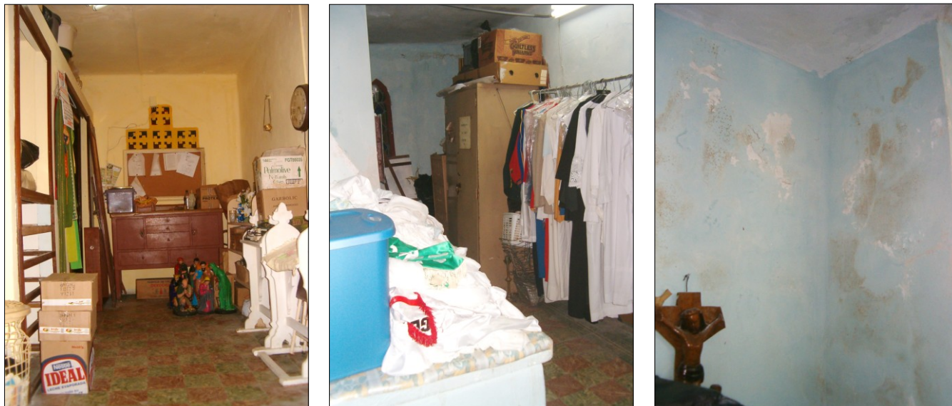
Fotos #25, 26 y 27: Vistas generales del “Lugar Sagrado”, del resto de la Sacristía y de los daños provocados por las filtraciones desde la losa de cubierta del ambiente
