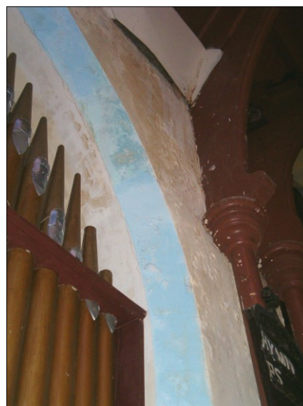
Fotos #19, 20 y 21: Vistas generales de los daños ocasionados por las humedades en los muros que conforman la Portada del Presbiterio, en donde se pueden apreciar manchas, grietas, eflorescencias, laminaciones de la piedra y pérdidas de adherencia. La foto derecha muestra los antiguos tubos del órgano que todavía se mantienen exhibidos.
