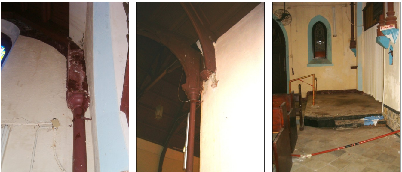
Fotos #13, 14 y 15: Izquierda: Vista general de los estragos causados por las humedades descendentes en muros y en los morteros de reemplazo de las secciones reemplazadas de los arcos de madera torneados. Centro: Pérdida de la columna torneada y de la ménsula del apoyo inferior de una cercha. Derecha: Vista general del antiguo "Altar de las Damas" y de su estado de conservación general.
