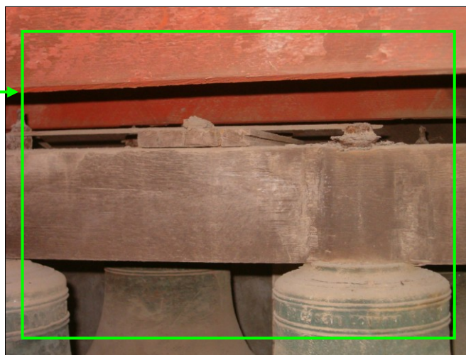
Fotos #30 y 31: Vistas generales del pequeño carillón y de la falta de estribos en varias de sus campanas.
