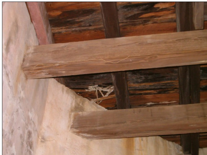
Fotos #28 y 29: Vistas parciales de las pudriciones en las maderas que soportan la Azotea y del estado de la campana principal de bronce ubicada en el tercer alto y de su mecanismo
