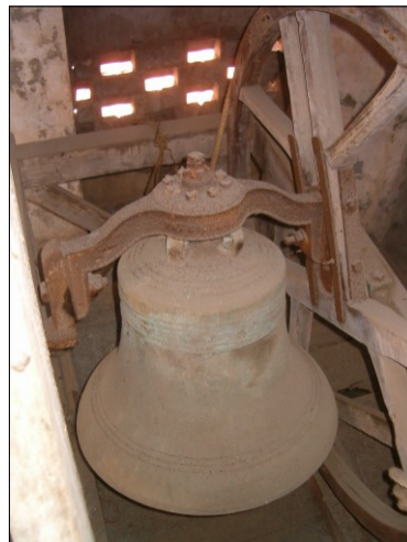
Fotos #28 y 29: Vistas parciales de las pudriciones en las maderas que soportan la Azotea y del estado de la campana principal de bronce ubicada en el tercer alto y de su mecanismo
