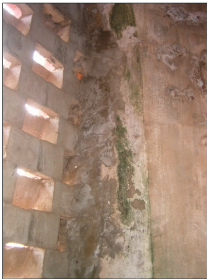
Fotos #32 y 33: Vistas generales de los severos daños encontrados en las mamposterías del primer nivel y de los daños generados por las humedades en los muros (crecimiento de algas, eflorescencias, manchas, etc.)
