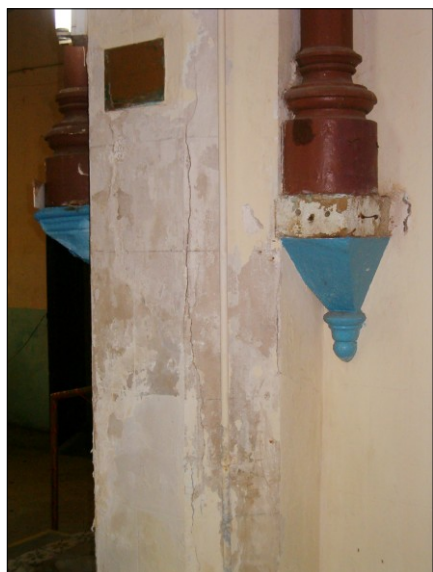
Fotos #19, 20 y 21: Vistas generales de los daños ocasionados por las humedades en los muros que conforman la Portada del Presbiterio, en donde se pueden apreciar manchas, grietas, eflorescencias, laminaciones de la piedra y pérdidas de adherencia. La foto derecha muestra los antiguos tubos del órgano que todavía se mantienen exhibidos.
