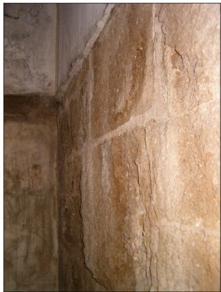
Fotos #32 y 33: Vistas generales de los severos daños encontrados en las mamposterías del primer nivel y de los daños generados por las humedades en los muros (crecimiento de algas, eflorescencias, manchas, etc.)
