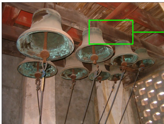
Fotos #30 y 31: Vistas generales del pequeño carillón y de la falta de estribos en varias de sus campanas.
