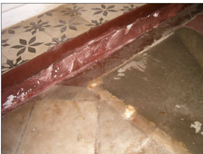
Fotos #22, 23 y 24: Vistas en donde se aprecian las pudriciones en una moldura por parte de hongos e insectos xilófagos, la separación de la cercha del muro testero y las eflorescencias en los pisos debido a las humedades ascendentes
