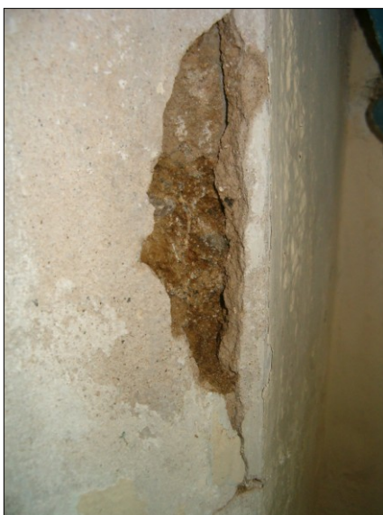
Fotos #19, 20 y 21: Vistas generales de los daños ocasionados por las humedades en los muros que conforman la Portada del Presbiterio, en donde se pueden apreciar manchas, grietas, eflorescencias, laminaciones de la piedra y pérdidas de adherencia. La foto derecha muestra los antiguos tubos del órgano que todavía se mantienen exhibidos.
