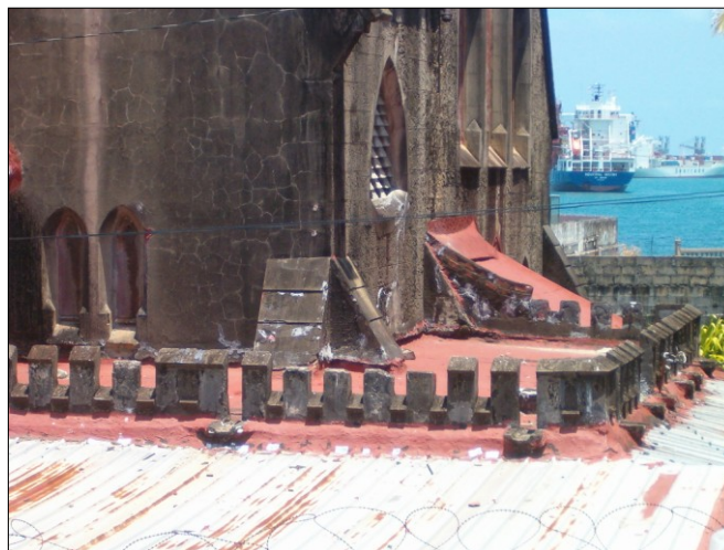
Fotos #3 y #4: Vista interior del encuentro entre las cubiertas de la Nave Central y el Crucero. A la derecha se aprecia la losa de concreto sobre la sacristía y su perímetro almenado, en la fachada lateral derecha y posterior.
