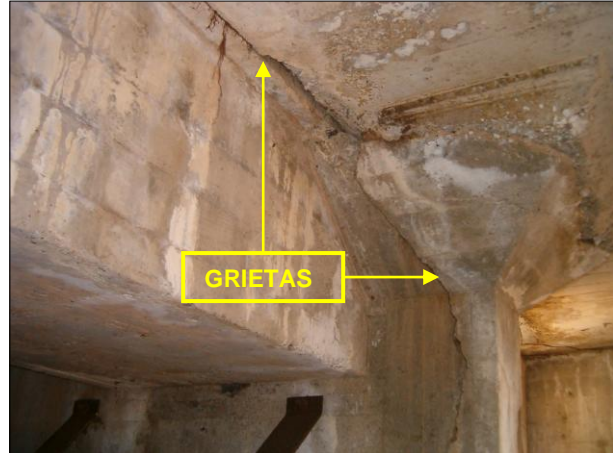
Fotografías #6 y #7: Vistas generales que muestran las grietas ocasionadas por el asentamiento diferencial que sufrió la Estructura #1, tanto el exterior como en el interior. En la fotografía de la derecha también se puede observar las carbonataciones del concreto que tiene la estructura.
